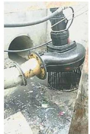
卡在防洪管井和升压泵的垃圾已清理干净，民众受促改掉乱丢垃圾的恶习，以免影响其抽水功效。
